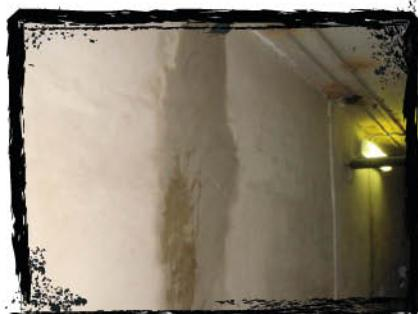
Протечка деформационного шва стены
