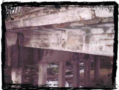
Несправности деформационных швов и неработающая гидроизоляция приводят к существенным повреждениям всех основных элементов мостового сооружения
