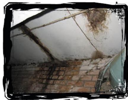
Течь деформационного шва и плиты
