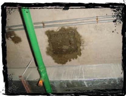
Протечка плиты перекрытия со следами неудачной попытки ее устранения
